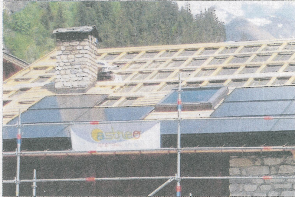
Les panneaux solaires sont encore en cours de montage : bientôt ils recouvriront la totalité du toit.
